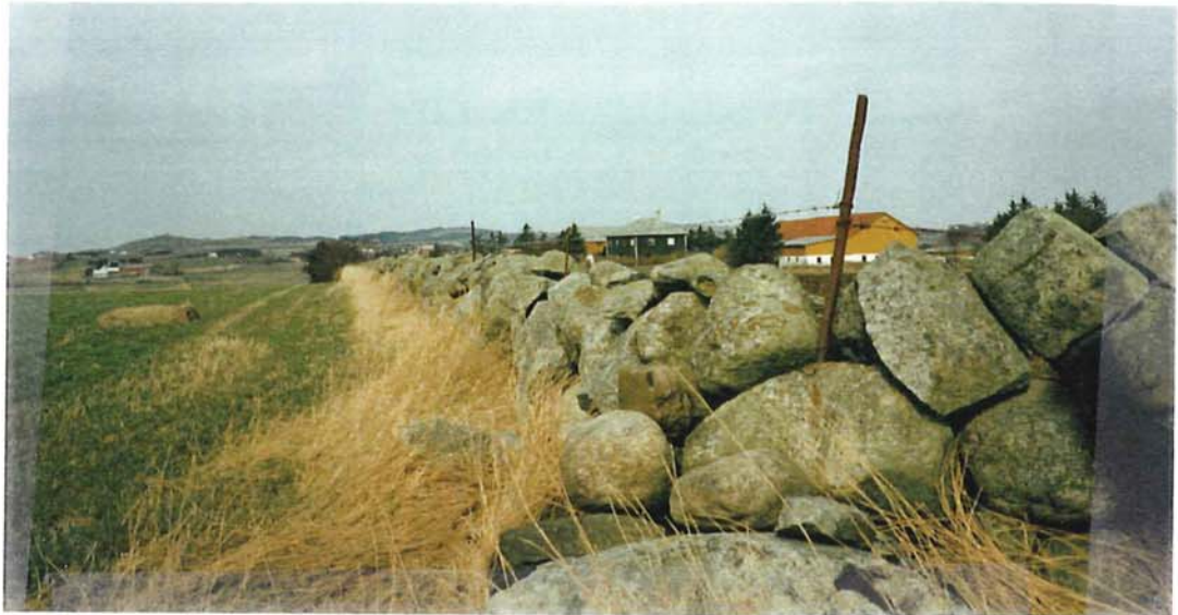
Figur 3: Steingjerde forsterka med piggråd.
