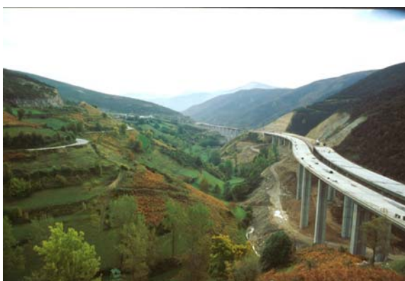
Figur 13: Motorvegen fra La Coruna til Madrid under bygging.
