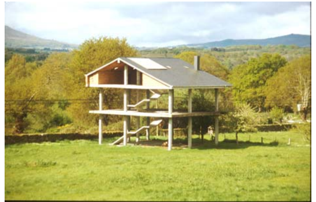
Figur 5: Et hus under bygging midt ute på et jorde. Etter all sannsynlighet er det en emigrant som kommer en eller to ganger i året for å bygge videre på sommerboligen.
