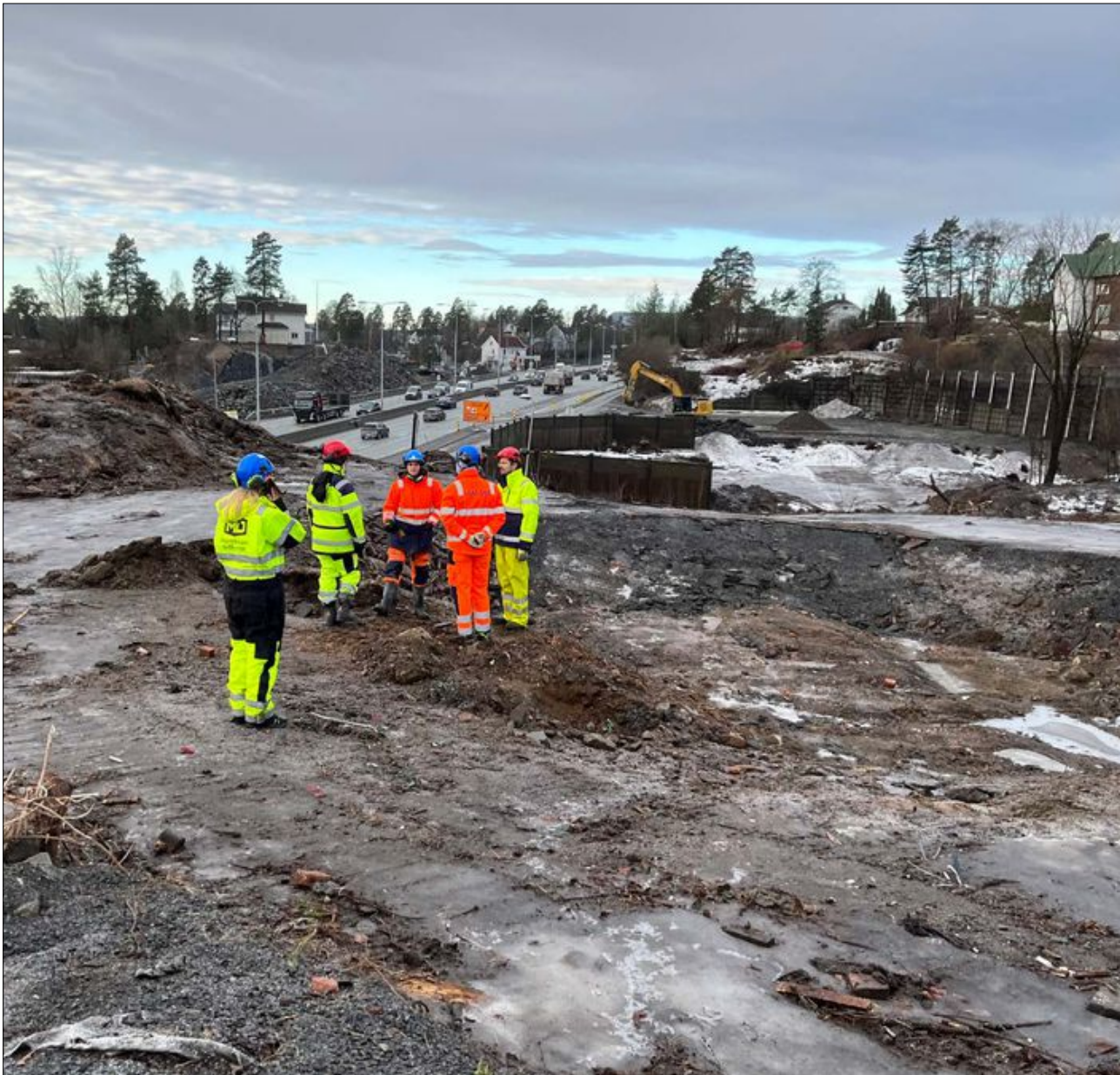
Store infrastrukturprosjekter, som her fra E-18, vil i årene som kommer generere store mengder med overskuddsmasser og avfall.
