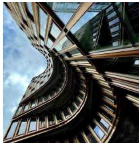
Via Vika - Ruseløkkveien 26, Oslo Fasader av resirkulært aluminium - plater produsert med minst 75% resirkulert aluminium fra tidligere brukte byggevarer. ark: Schmidt Hammer Lassen
