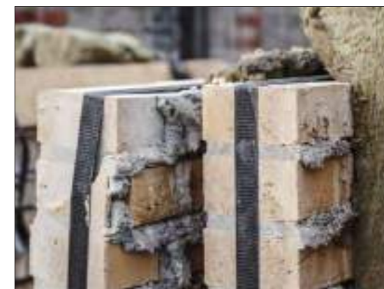
Ressursrekkene, København - Lendager Gruop Resirkulert murstein og avfallstre, en resirkulert betongbjelke som brukes som bro og gamle vinduer og avfallstre som hytter i felleshager på taket med en atmosfære av kolonihager.
