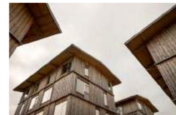
Boliger Lisbjerg Bakke - Danmark Design for disassembly, modulbyggeri ark: Vandkunsten
