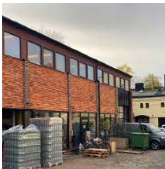
Gamlebyen Loft, Oslo Den originale mursteinsfasaden har blitt demontert og bygget opp igjen med en kombinasjon av lokalt ombrukt tegl og skjermtegl av oppsirkulert teglavfall. ark: Moi arkitekter / Høine AS
