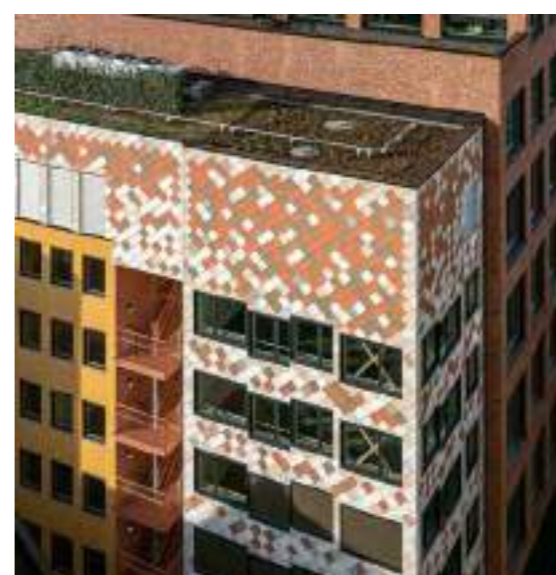
Kristian Augusts gate 13, Tullinløkka Oslo Fasadekonsept basert på ulike platetyper: anskaffet via Finn.no, overskuddslageret på Steni-fabrikken og noe demontert fra Oppsal sykehjem. Bearbeidet til mosaikk i mindre formater, og med en fargepalett tilpasset eksisterende fasader. ark: MAD
