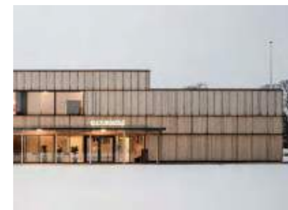
Rakkestad Kulturskole Fasader: malmfuru - isolert med trefiber ark: Oslo Tre / Fragment
