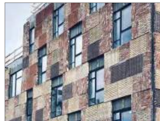
Ressursrekkene, København - Lendager Gruop Et innovativt konsept er å gjenbruke mursteinsfasader fra forlatte strukturer i det nye bygget, og spare så mye som 29 % CO2 ved å resirkulere kun 10 % av alle byggematerialer.
