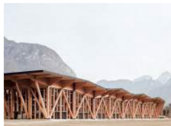
Kongressenter, Agordo, Italia Fasader med synlige trekonstruksjoner med respekt for både miljøet og den alpine byggeskikken. ark: Studio Bressan og Studio Botter
