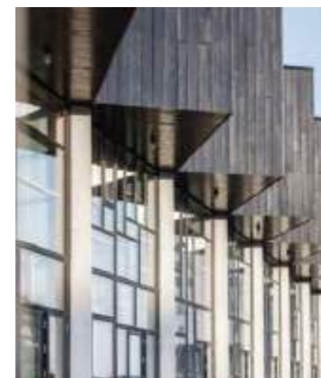
Upcycle Studio - boligprosjekt Danmark Resirkulert betong, gjenbrukte vinduer og kasserte gulvplater fikk nytt liv i prosjektet ark: Lendager Group
