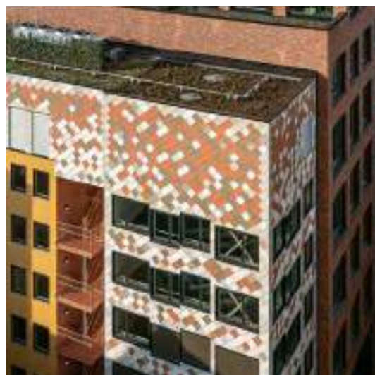
Kristian Augusts gate 13, Tullinløkka Oslo Gjenbruksprosjekt - bevaring+nybygg. Mange nye elementer er gjenbrukte elementer fra andre bygg. ark: MAD
