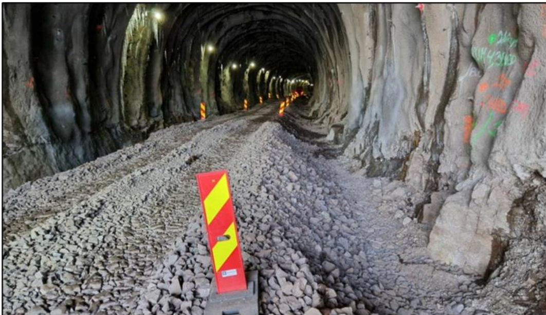
Figur 1 Bunnrensk er masser som utgjør den midlertidige kjørebane i tunneler under anleggsfasen (bildet er hentet fra Anlegg og Transport, at.no).
