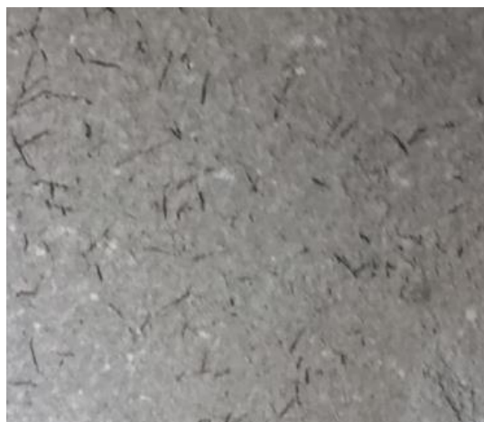
Figur 6 Stålfiber benyttet for armering av sprøytebetong kan potensielt forekomme i bunnrensk (venstre: stålfiber fra mapei.com, høyre: stålfiber som stikker ut av sprøytebetongen i en tunnelvegg).
