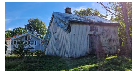
Personlig fotografi: Bilde av Svensrødhuset tatt på befaring (Sirianna Stormo Pettersen, 2024)
