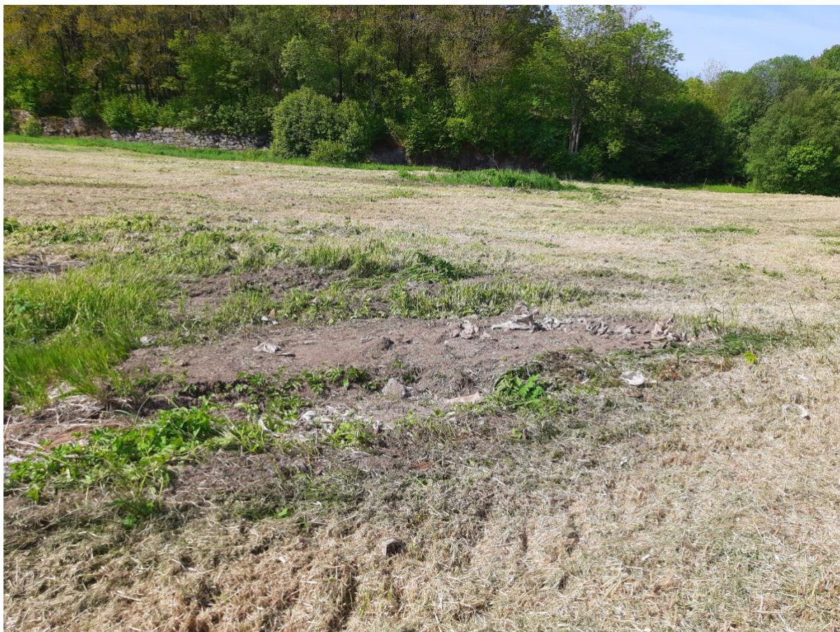
Figur 2: Toppdekket ved Ytre Hope deponi, med synlig avfall som tyter opp gjennom toppdekket. Bilde: Anna Hatland v/ Bergen Kommune.
